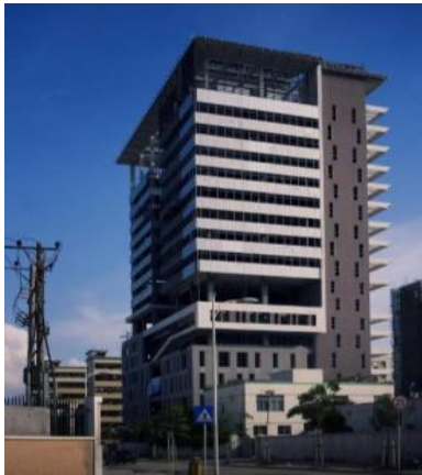
深圳建科大楼（三星级）
