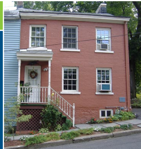
85 Nicoll St. post-retrofit.
